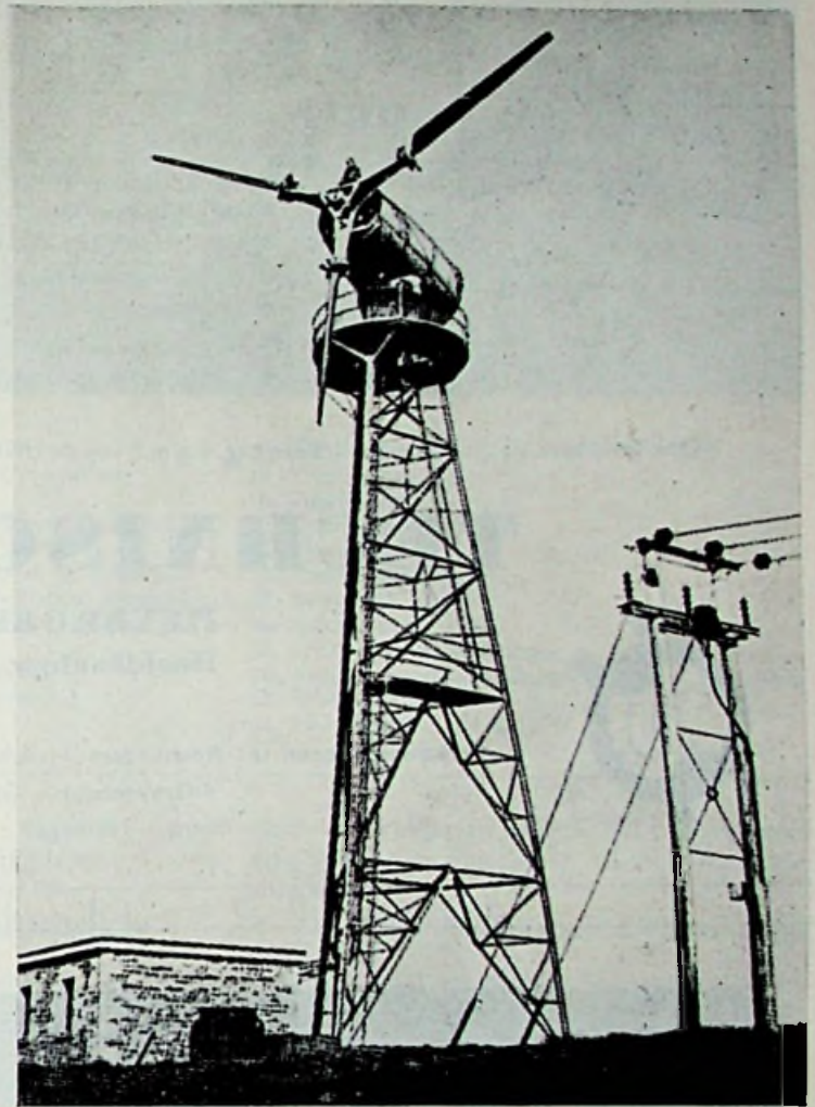
Fig. 1. De 100 kW windmolen-generator met transformatorhuis op Costa Head.
