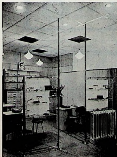
Een andere toepassing en uitvoering van het Unipro-plafond.
